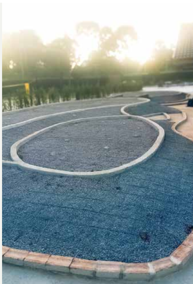
Campo de mini-golfe em execução
